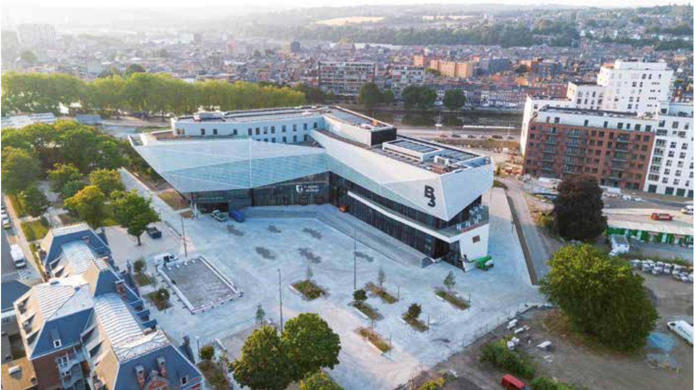
B3 a été pensée comme partie prenante de la réhabilitation de tout un quartier
