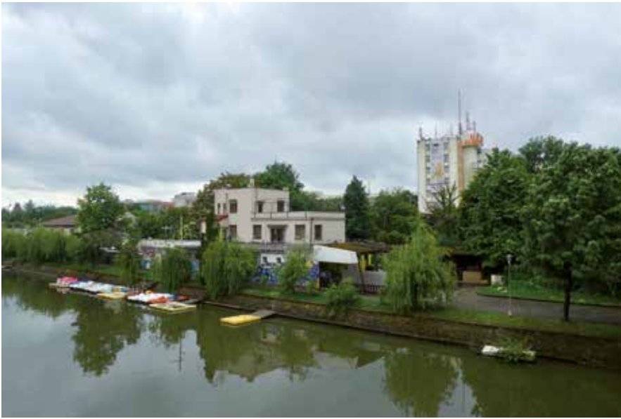
UPT Electro, bâtiment de la Faculté d'ingénierie électrique et énergétique au bord de la rivière Bega qui est un lieu d'expérimentations de solutions durables
